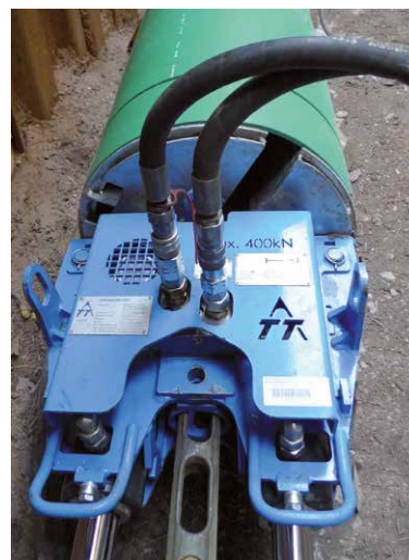
BURSTFIX 400 im Einsatz.
